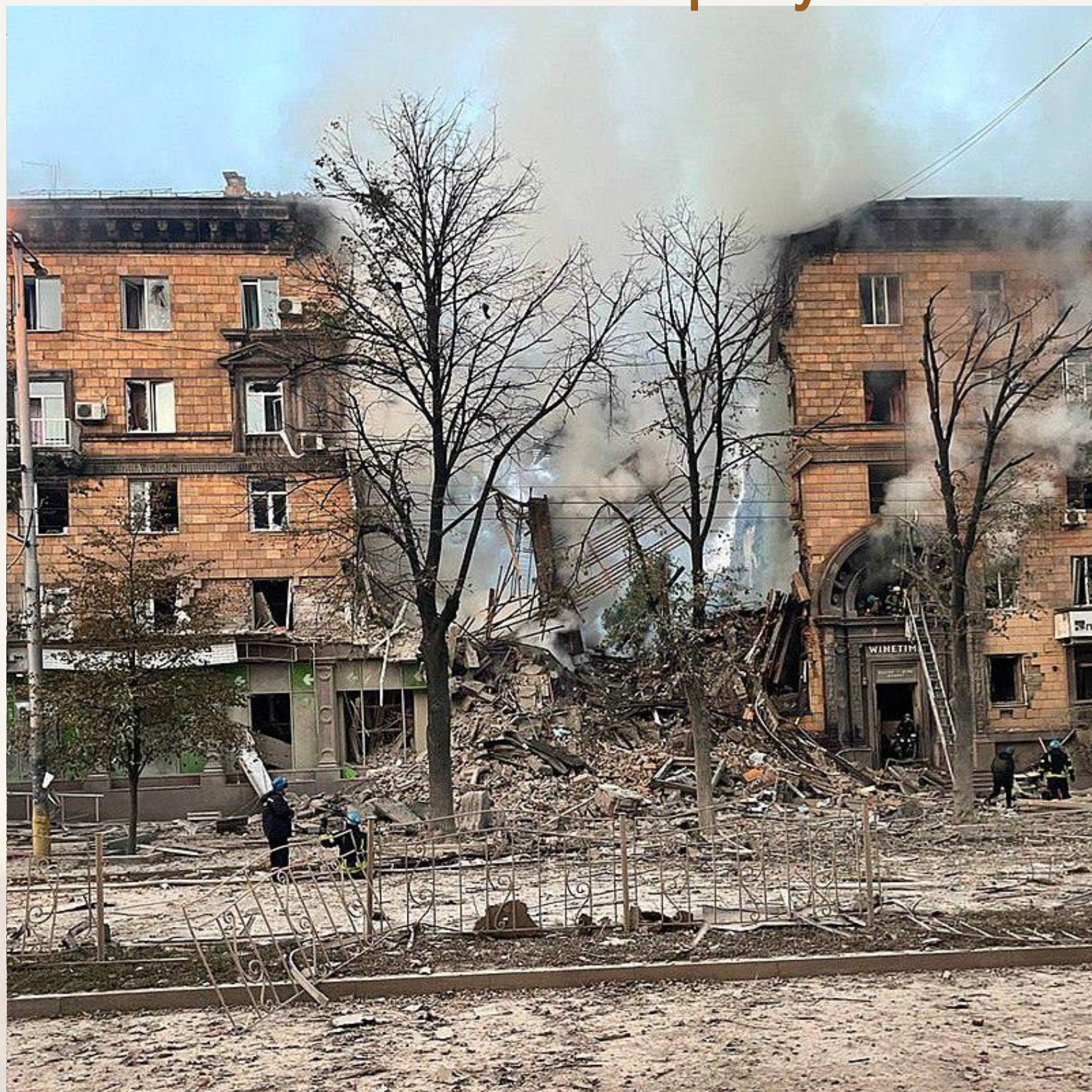
Будинок після обстрілу 6 жовтням 2022 року
